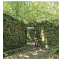
集成館事業の燃料用木炭を製造した炭窯跡。1858年建設の炭窯跡が残り、炭窯本体は堅牢な石積から成る当時の姿を残す。斉彬は集成館事業による木炭供給不足に備え、吉野町寺山に強火力の白炭を製造する炭焼窯設置を命じた。
