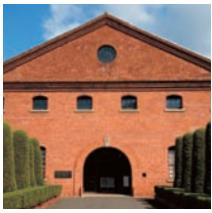
三菱合資会社時代の木型場。鋳物製品の需要増に応じ建設。木骨煉瓦造二階建てで鋳型製造の木型を製作。1985年長崎造船所の歴史を紹介する「史料館」として生まれ変わり、現在は同造船所が一般公開している唯一の施設。
