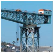
三菱合資会社時代、設備電化に伴い同型としてわが国に初めて建設された英國アップルビー社製電動クレーン。大型舶用設備品の吊上荷重に耐え電動モーターで駆動する等当時最新。現在も蒸気タービンや大型舶用プロペラの船積みに使用。
