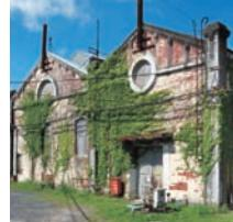
製鐵所の送水施設。製鐵所第一期拡張計画に伴う工業用水不足を補うため、1910年に操業開始。明治建築の典型的な煉瓦建造物。動力は蒸気から電気に変わり、現在も現役で稼動中。
