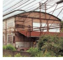
1900年、製鐵所建設に必要な鍛造品製造を行う目的で、修繕工場と同様ドイツのGHH社の設計と鋼材を用いて建設された鉄骨建造物。製鐵所の拡張工事により増築され、1917年に現在地へ移築され、製品試験所として使われた。
